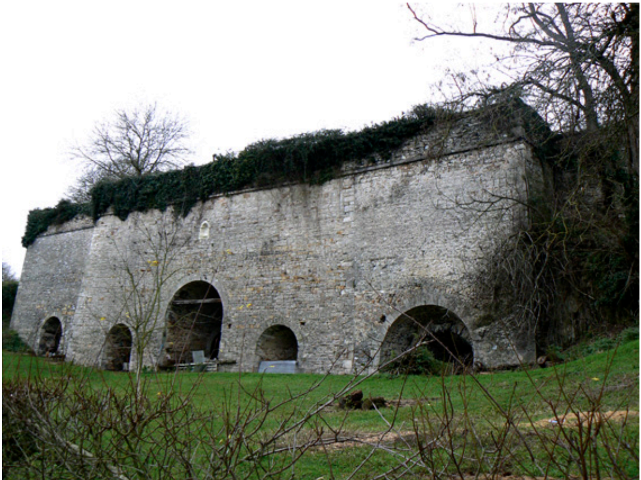
Façade orientale des fours à chaux.
