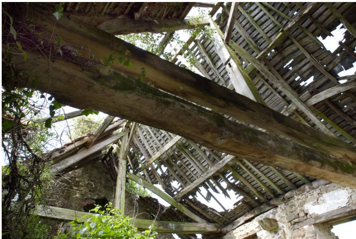
La charpente vue depuis le nord.
