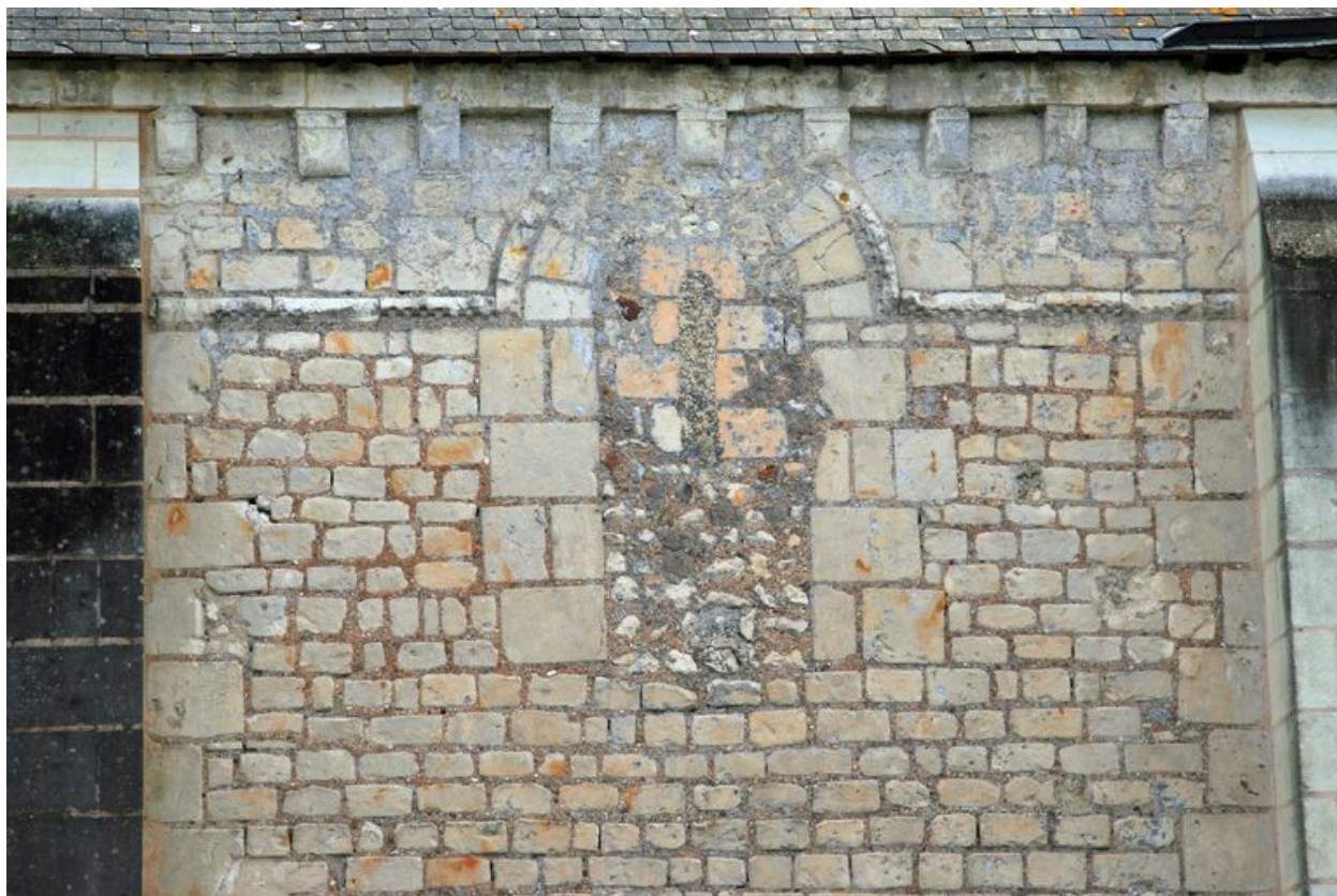
Face nord, 2e travée de la nef : baie en plein cintre bouchée avec l'aménagement d'une baie plus petite.
