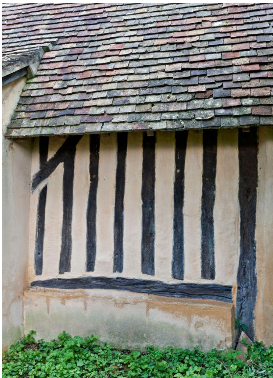
Le Carrefour. Détail de l'élévation postérieure du logis.
