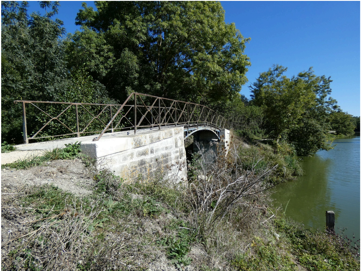
La passerelle vue depuis l'ouest.
