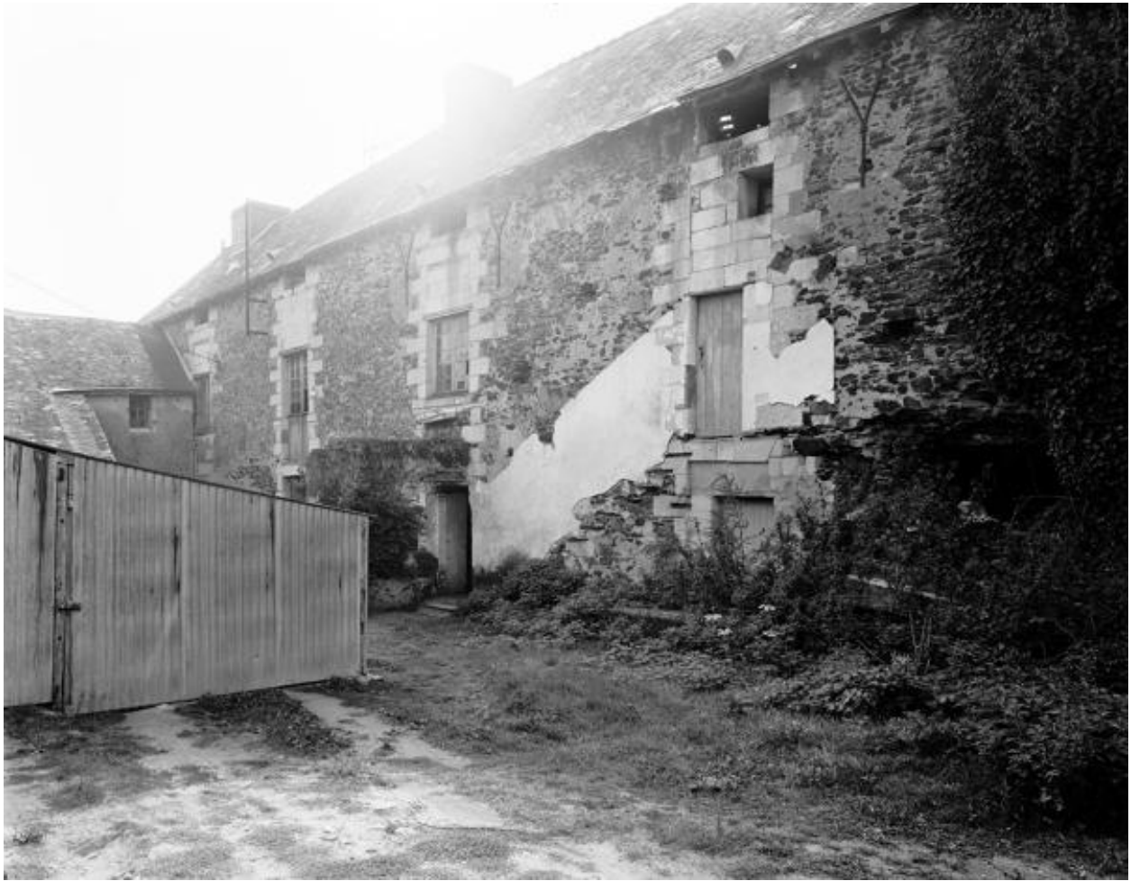
Façade antérieure du manoir, partie centrale.
