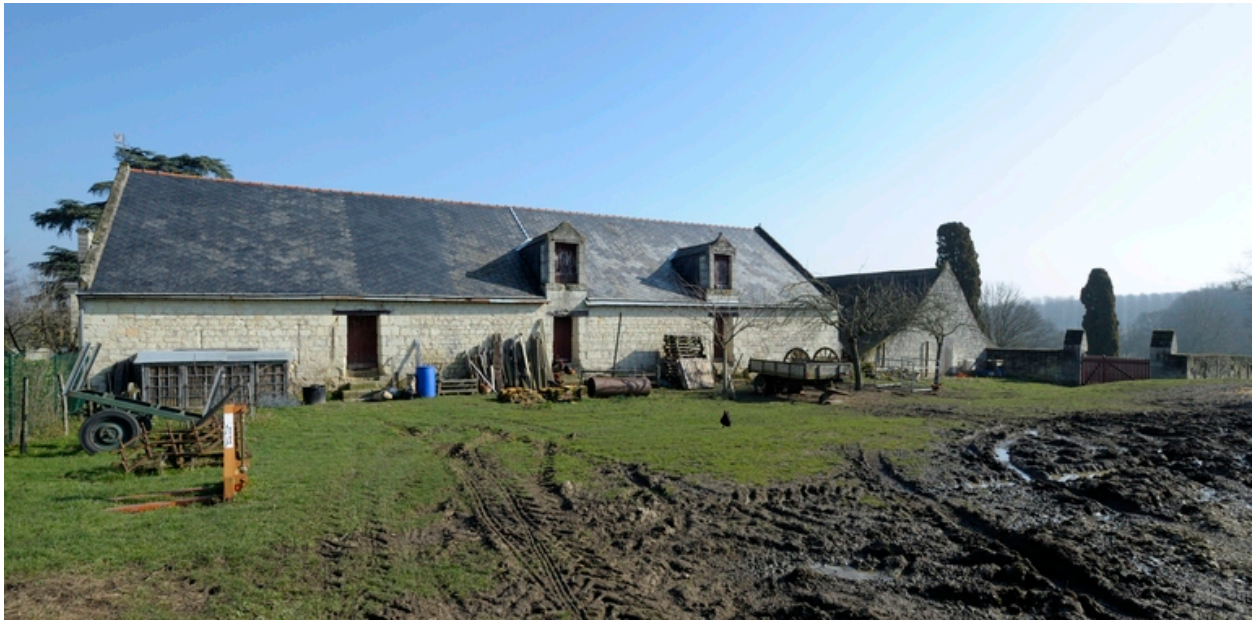
Dépendances agricoles, façades postérieures (2).
