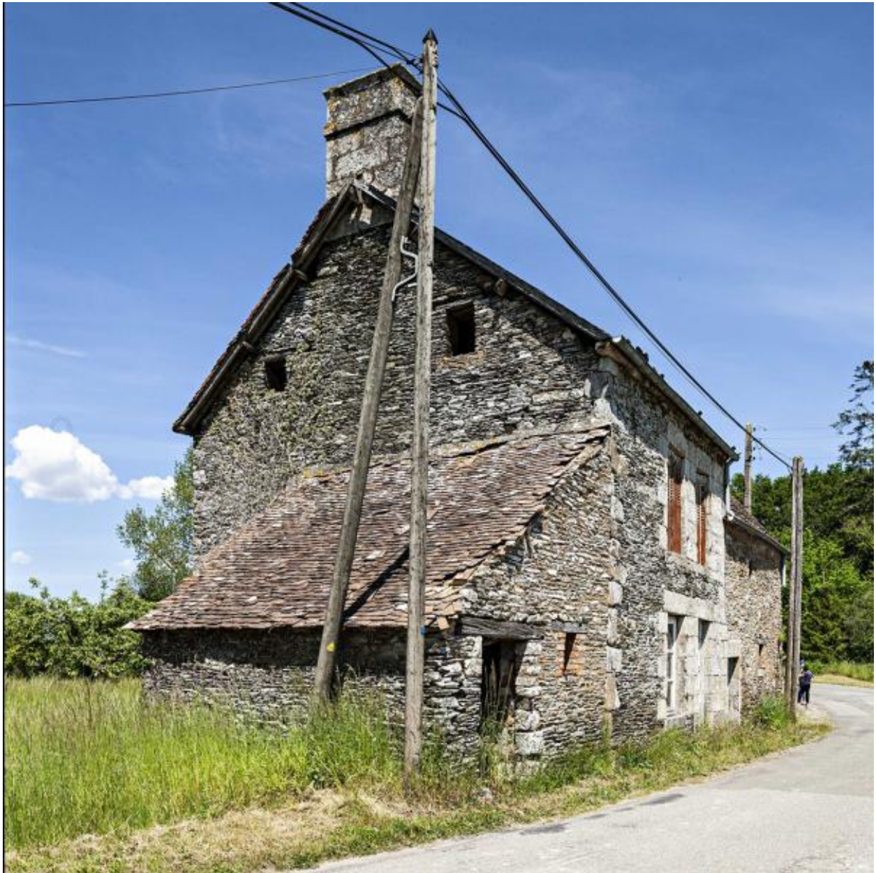
4 Bourgeray (2023 ZH 70), remise en appentis contre maison
