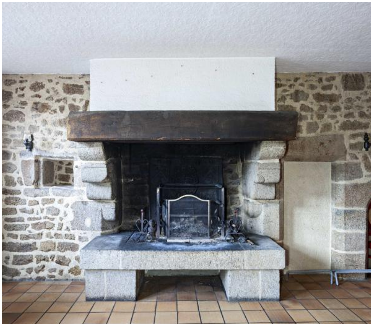
2-4 place du 8-Mai-1945, cheminée et porte du mur de refend.
