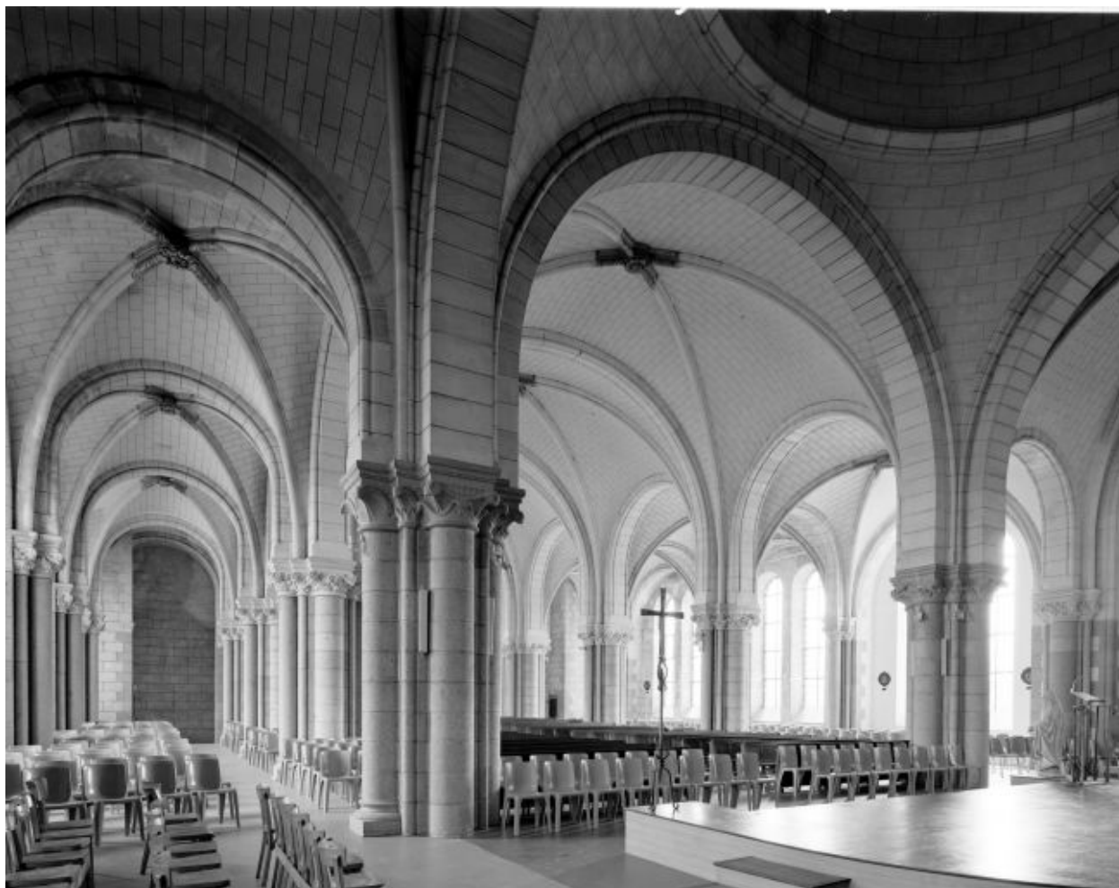
Premier étage : vue d'ensemble.
