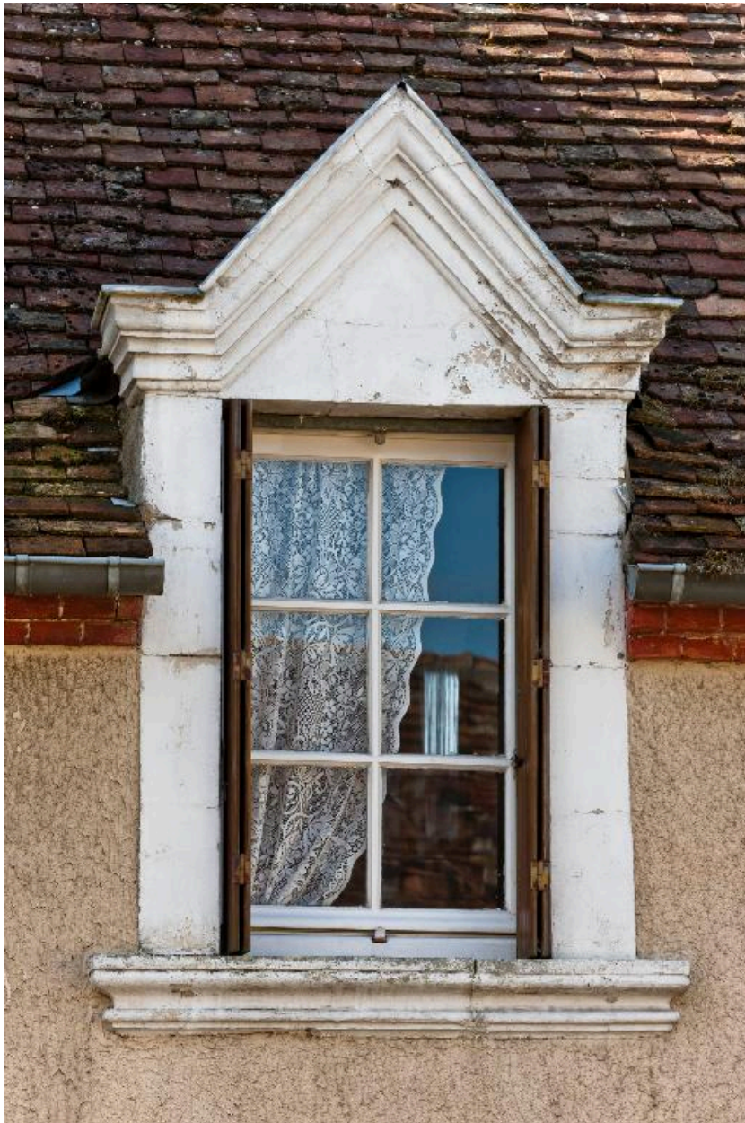
9, rue des murs. Lucarne du logis.
