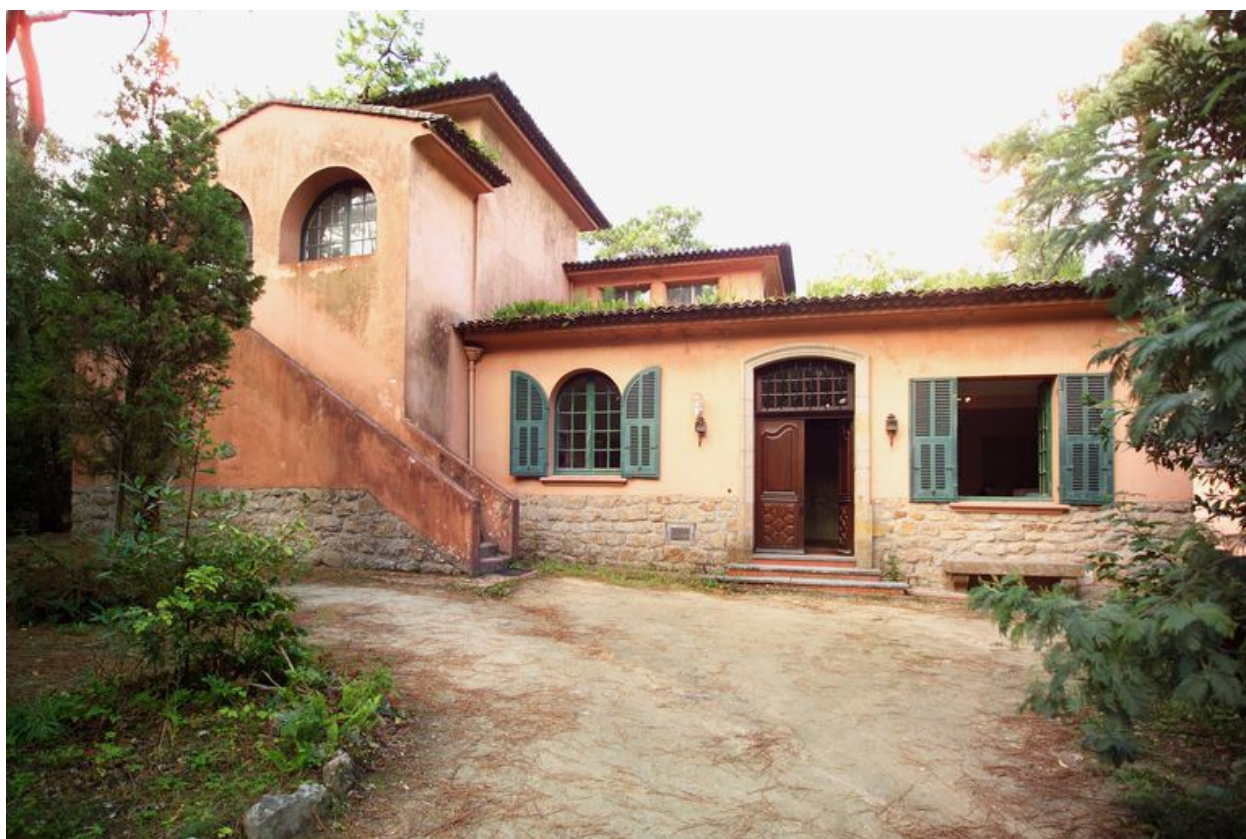
Façade est de la villa Maritaye.
