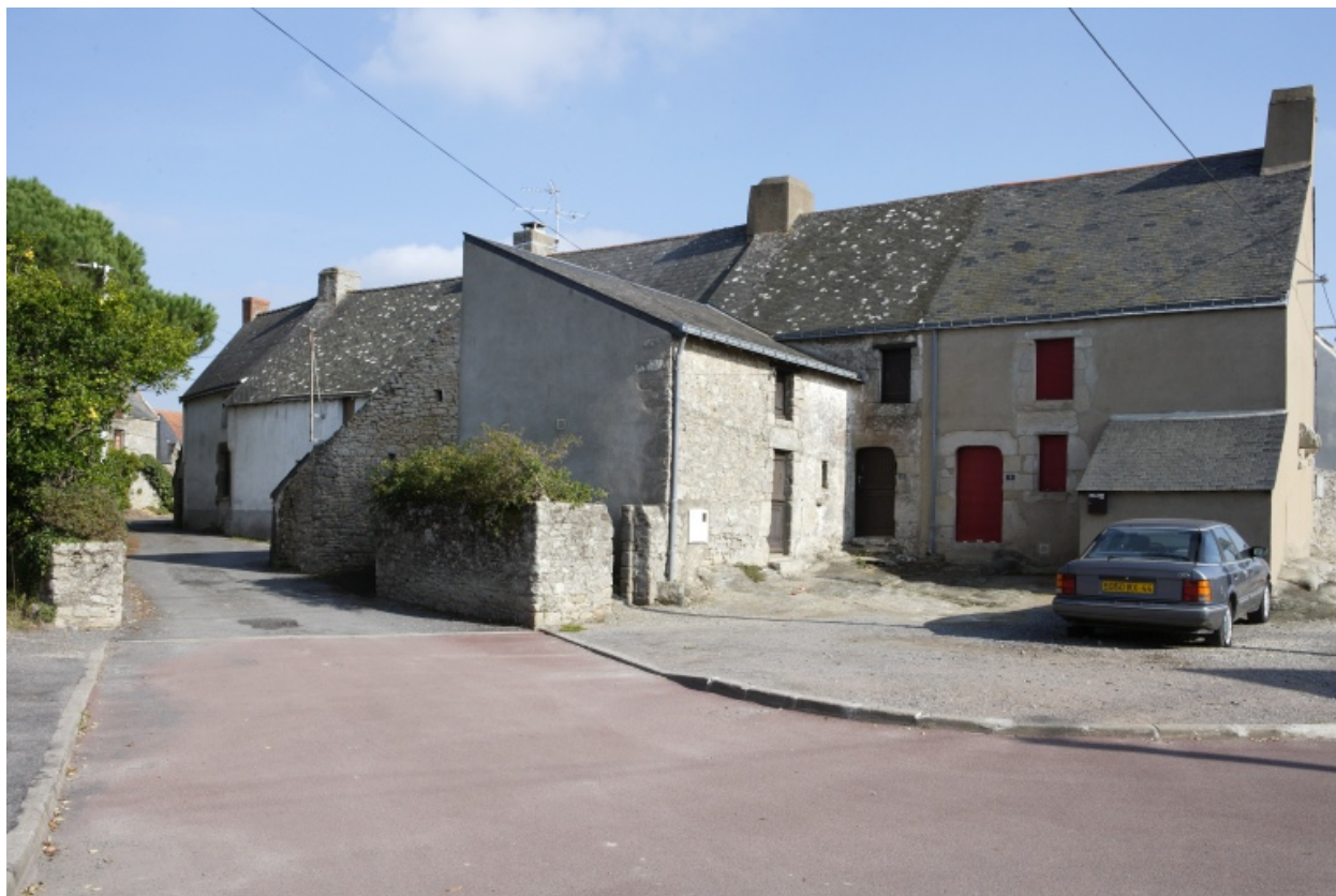
Vue d'ensemble de la rangée depuis l'ouest.
