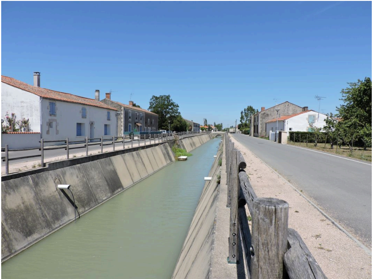
Le canal dans la traversée du village du Pont aux chèvres, vu depuis le sud-ouest.
