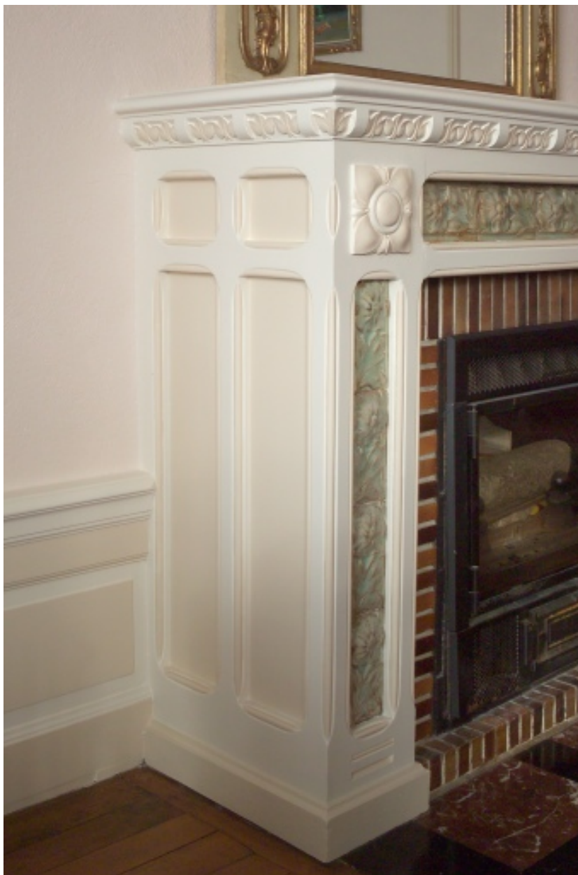
Détail de la cheminée du salon sud.
