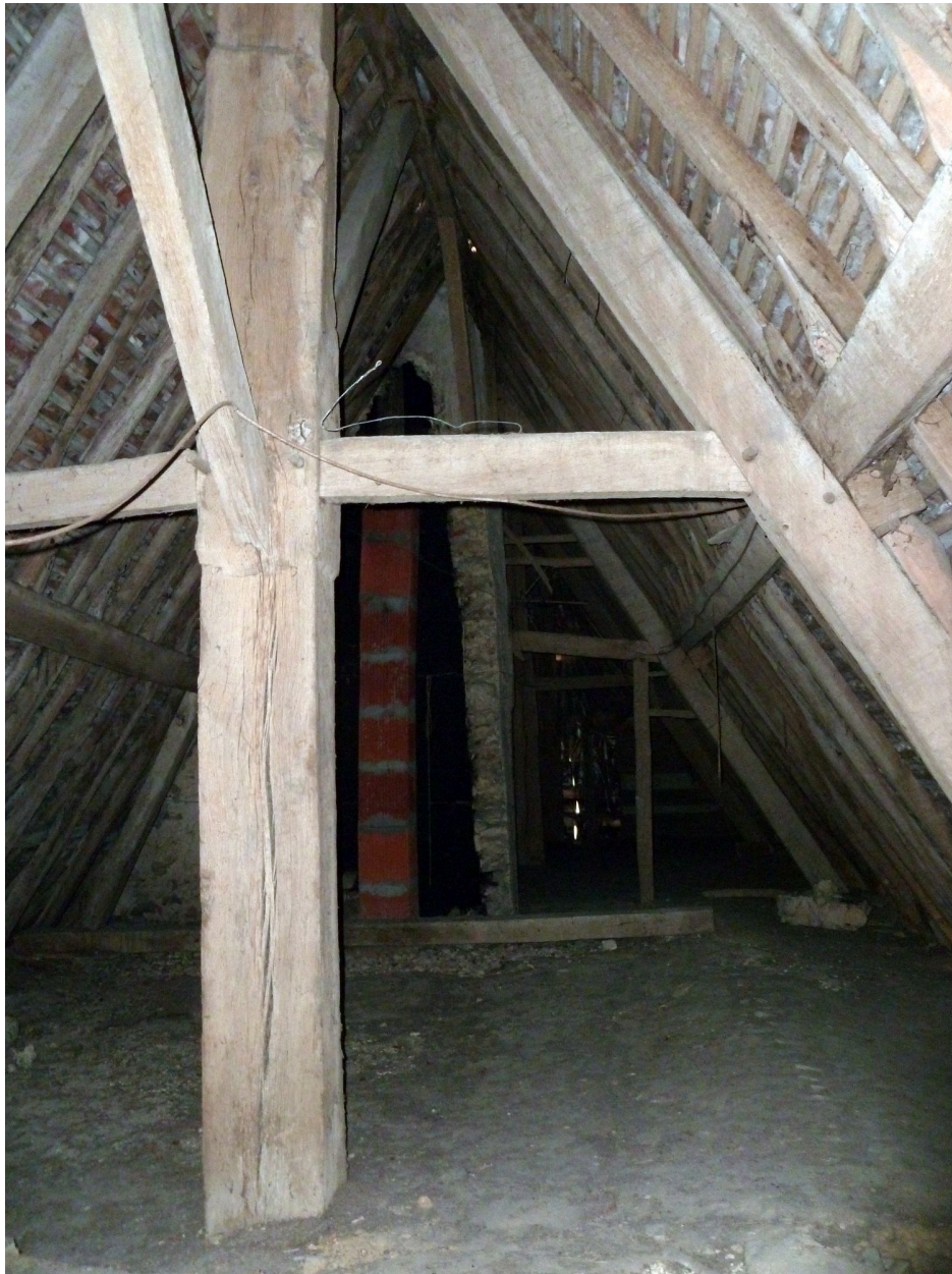
Charpente à fermes à faux entrails et pannes de l'aile en retour.
