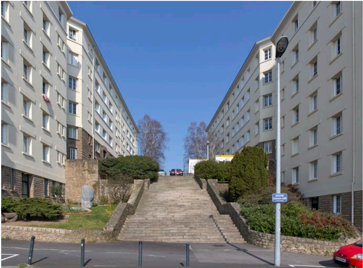
Escalier situé entre les bâtiments C et D.
