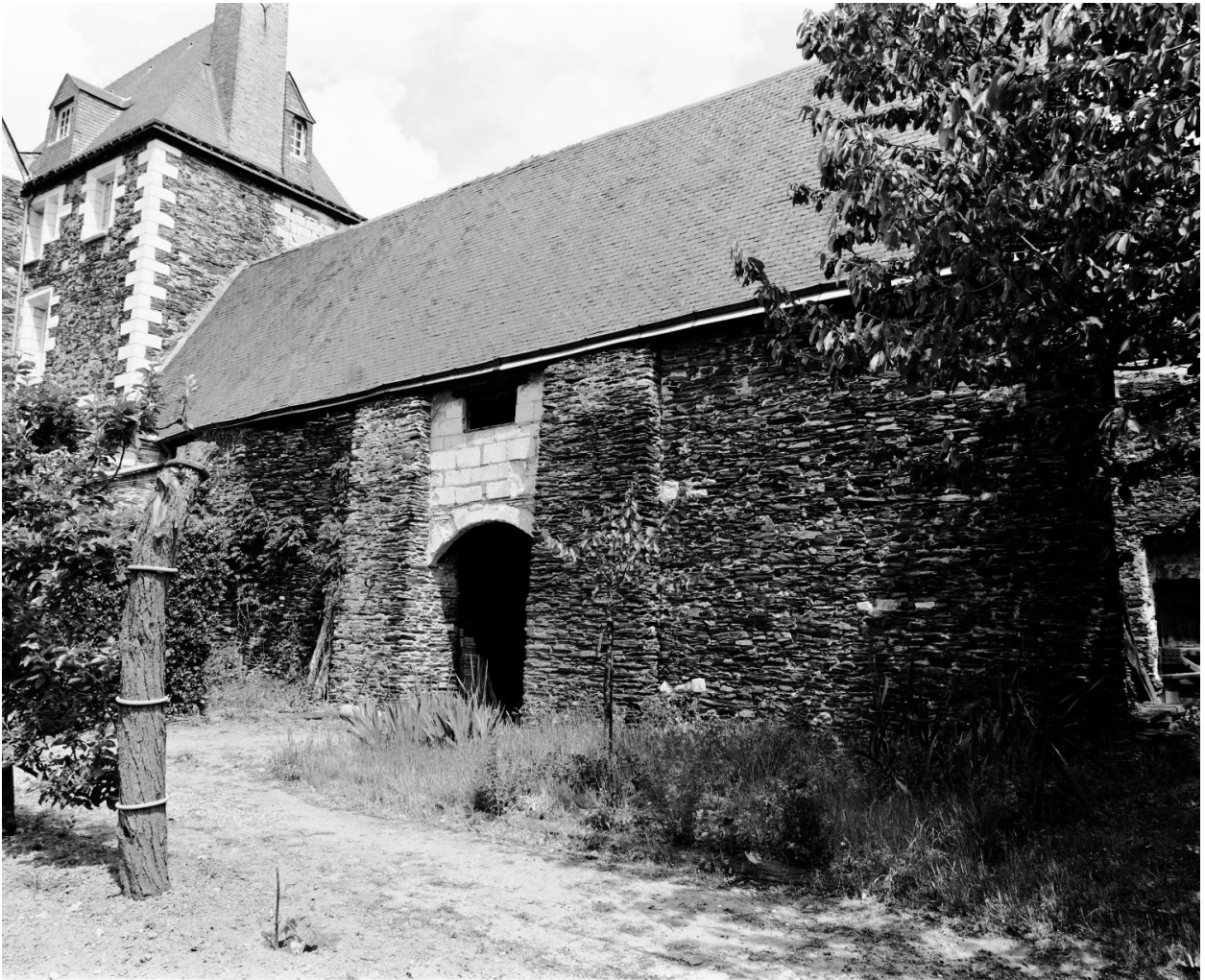
Dépendance attenante au bâtiment dit des lieux communs : élévation sud, sur le jardin.
