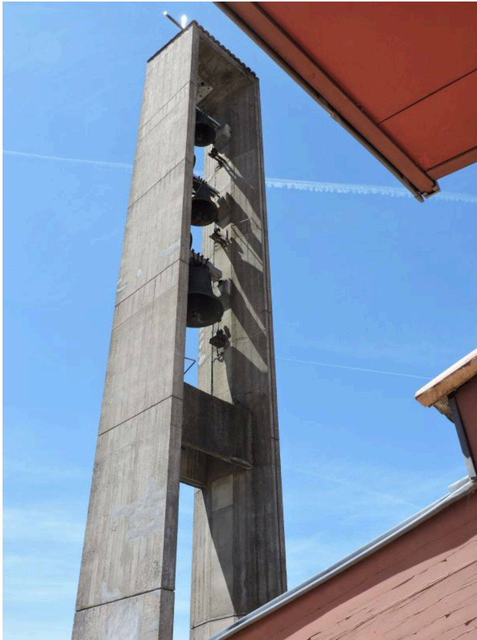
Le clocher vu depuis le nord-est.
