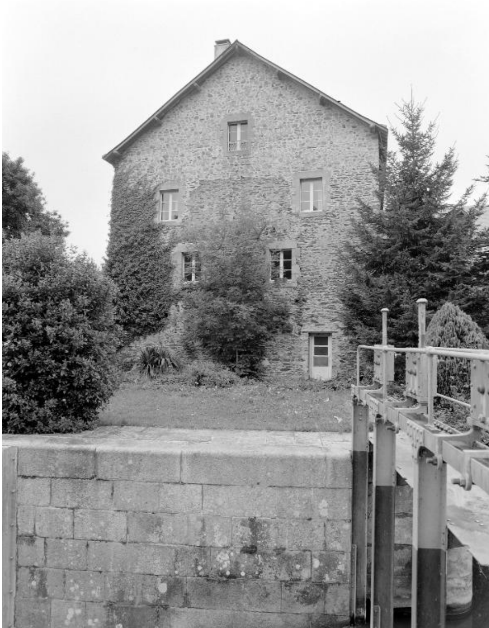
Elévation sud-est du moulin, sur la rivière. Au premier plan, le pertuis.
