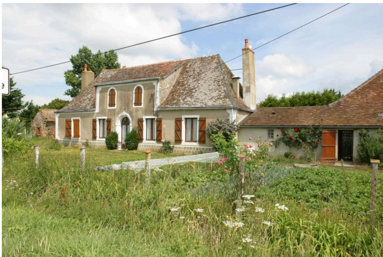
L'élévation principale du logis vue depuis le sud-est.
