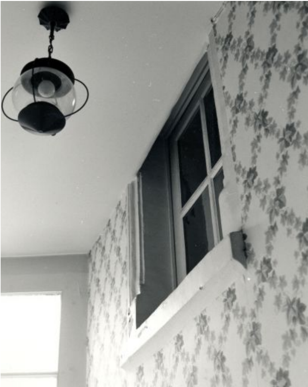
Tour d'escalier : fenêtre sur la face latérale droite à hauteur du 1er étage.
