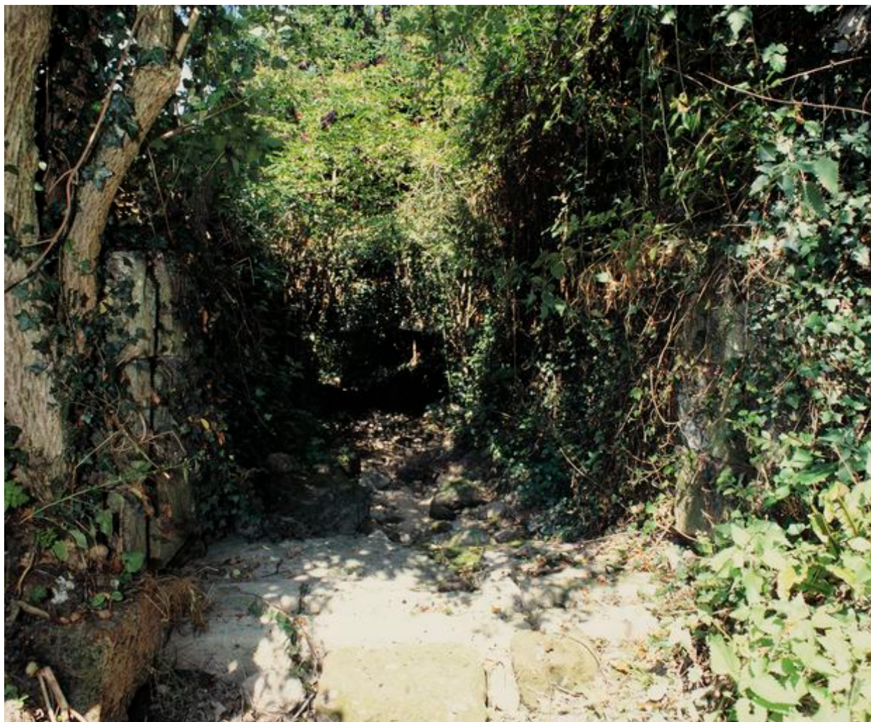
Le cours canalisé de l'Arceau en amont de la boucherie.
