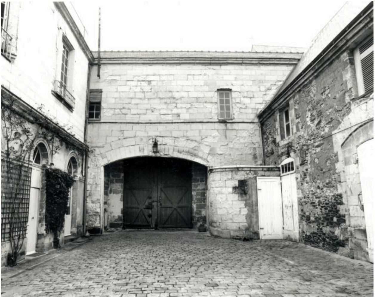
Corps d'entrée : élévation postérieure, sur la cour. A gauche, le logis. A droite, les écuries.
