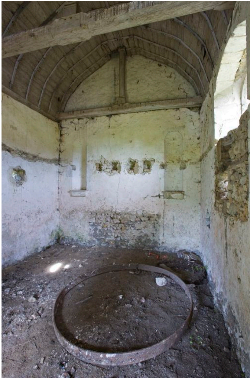
Vue intérieure depuis l'entrée
