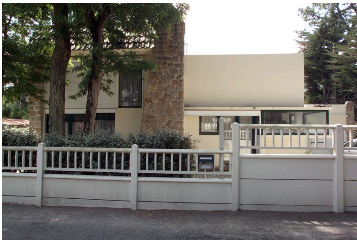
Vue d'ensemble de la villa Hon Daou.
