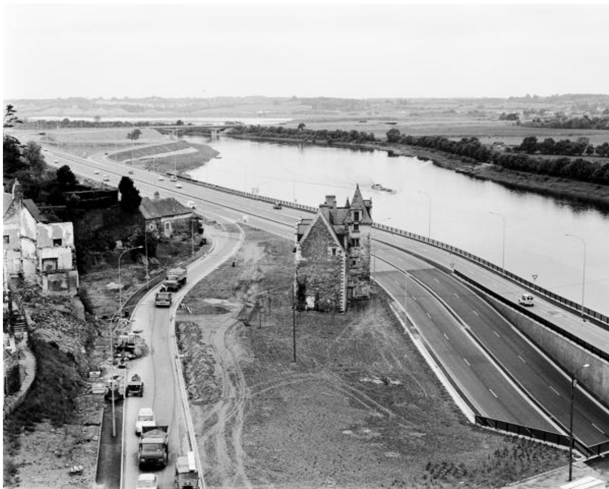
Vue de situation depuis le nord-est.
