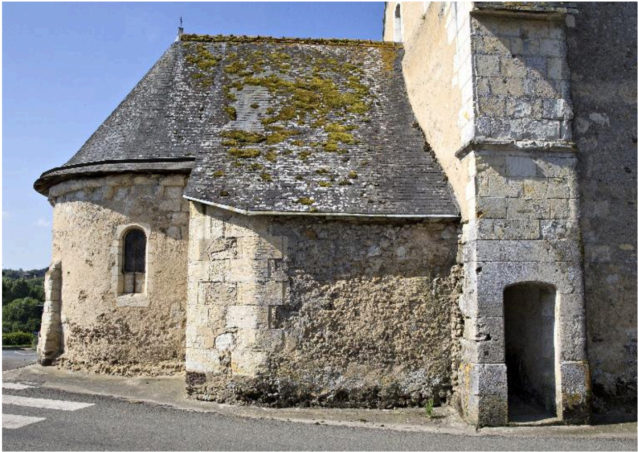
Abside et chœur, chapelle des Ronsard et entrée seigneuriale dans un contrefort de la nef, pris depuis le nord.
