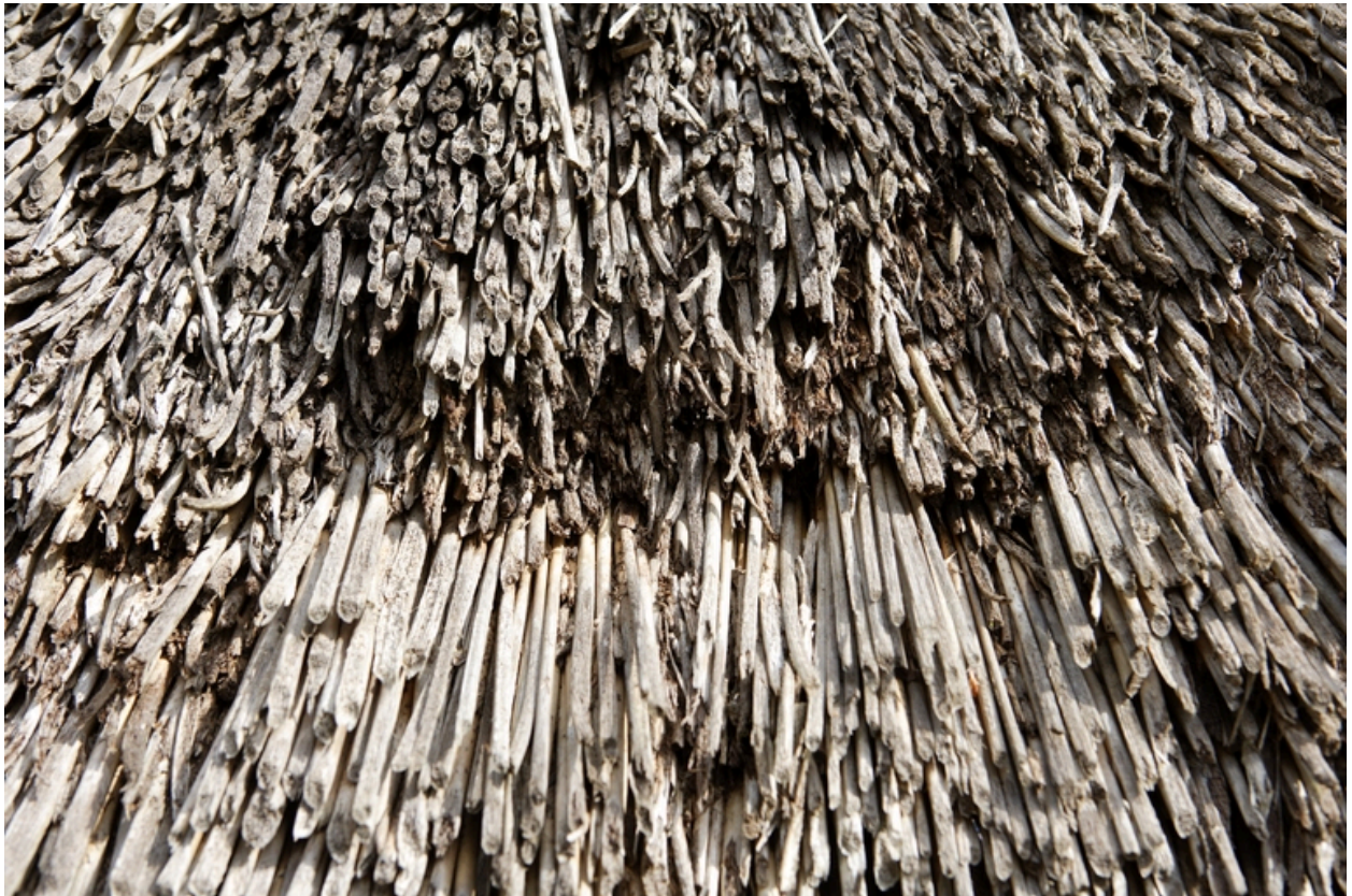
Détail de la couverture en roseau de l'écurie.
