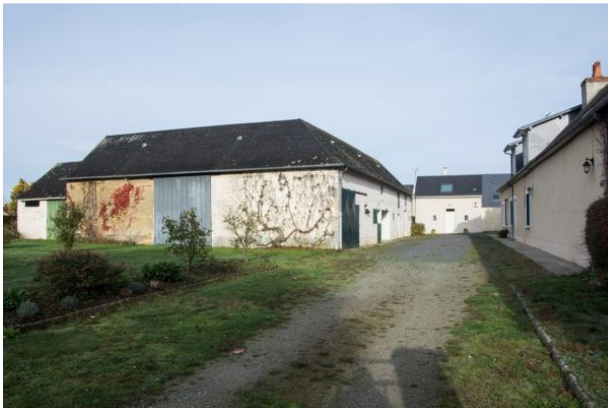
Vue d'un ensemble agricole rue Prémartine.
