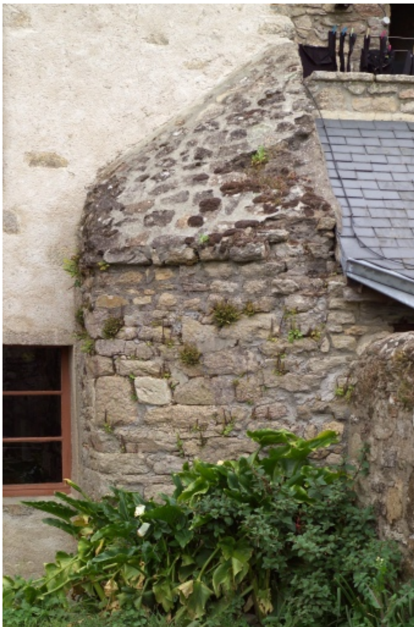
Façade arrière, détail de maçonnerie.
