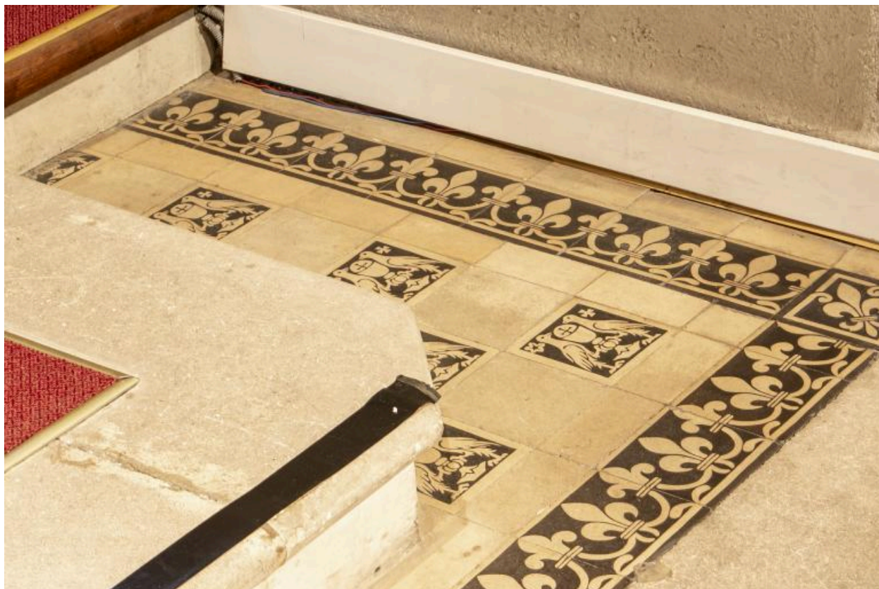
Vue du dallage dans la chapelle.
