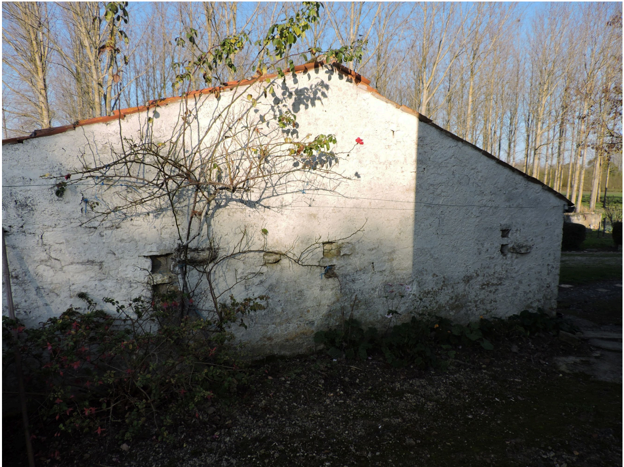
Le mur pignon sud de l'étable, avec attaches pour animaux.
