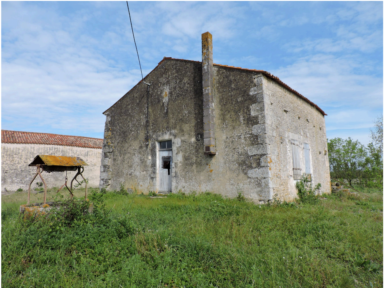
Le logis vu depuis le sud.
