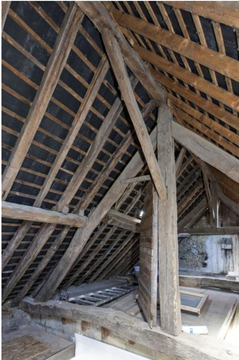
Ensemble 2, logis sud, charpente, ferme centrale.
