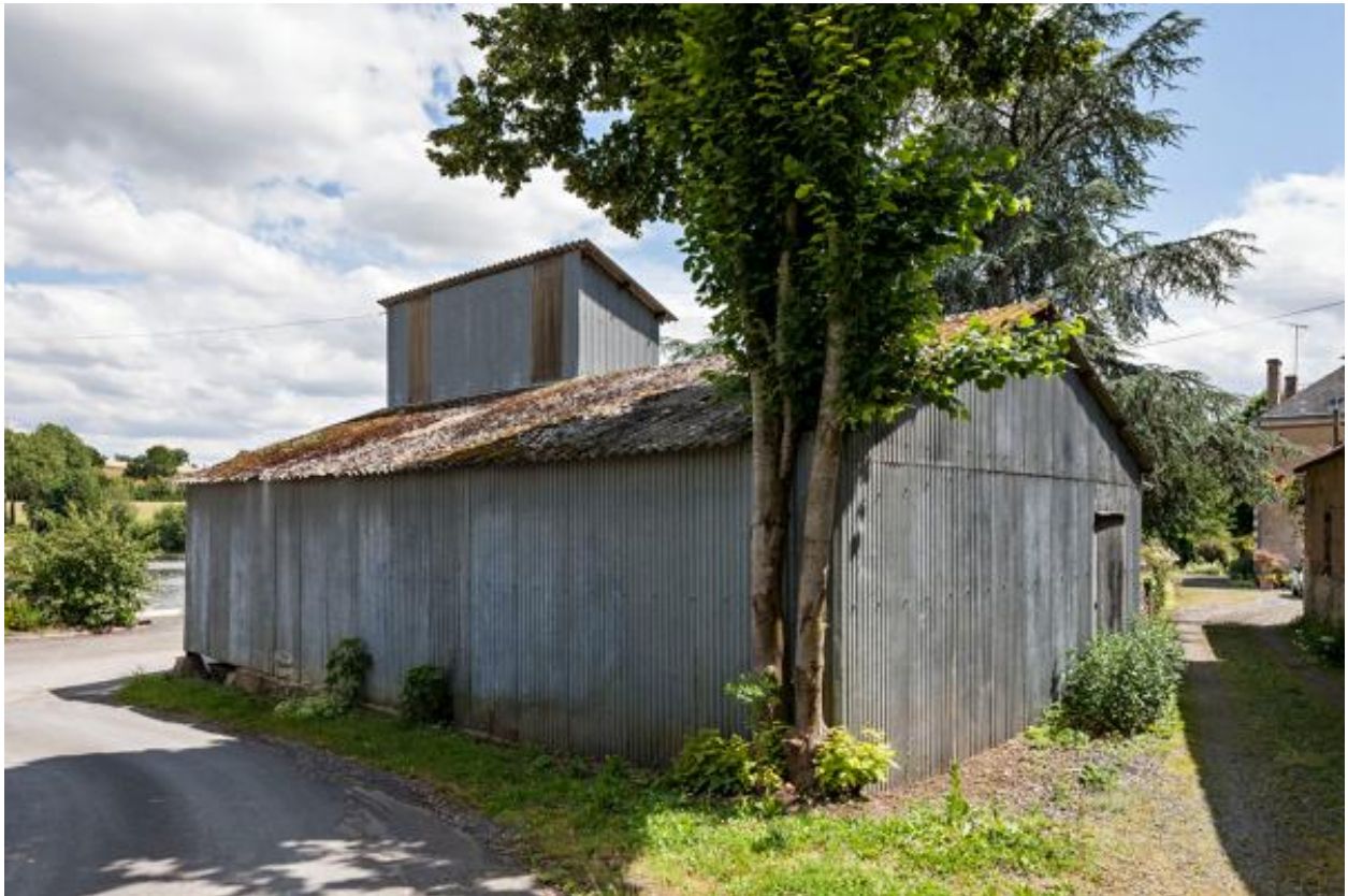
L'entrepôt à grains construit à la fin des années 1950, vu depuis le nord.
