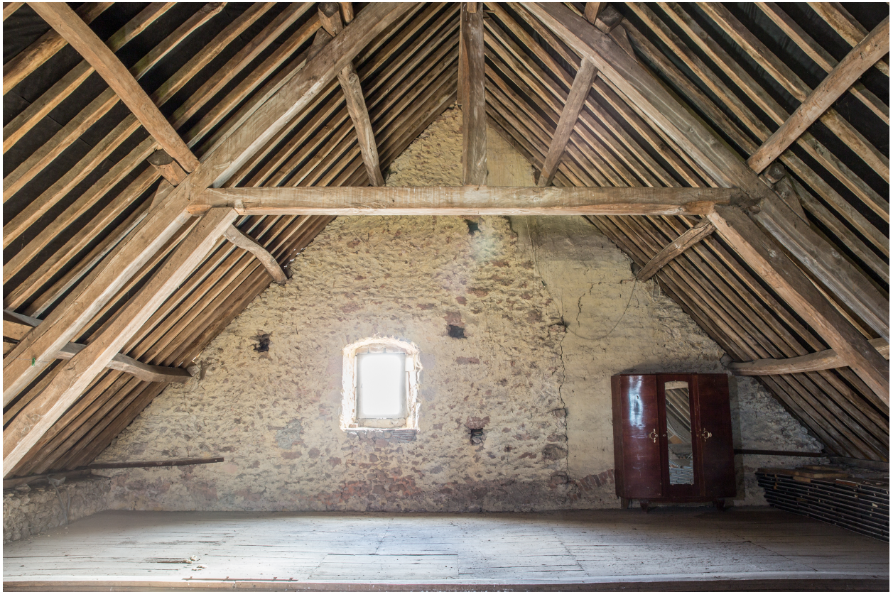
Le comble et la charpente.
