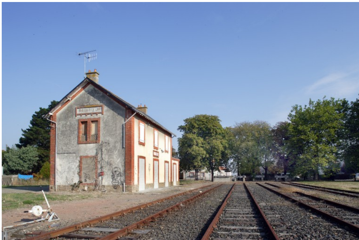
La gare de voyageurs vue depuis le sud.
