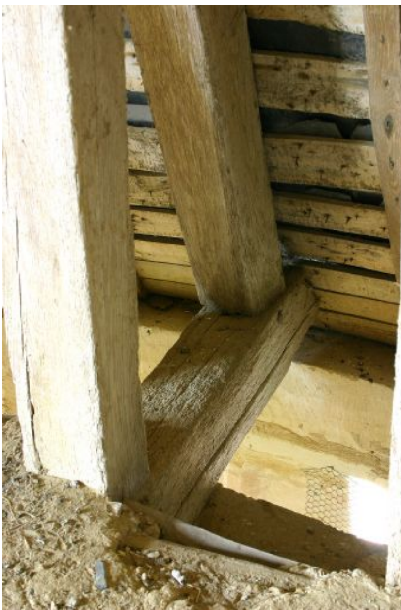
Le chemin de ronde vu du comble actuel.
