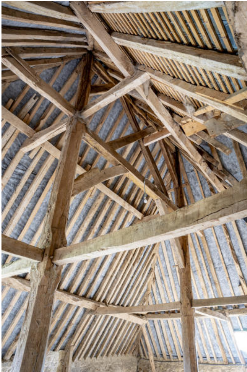
La charpente du pavillon.
