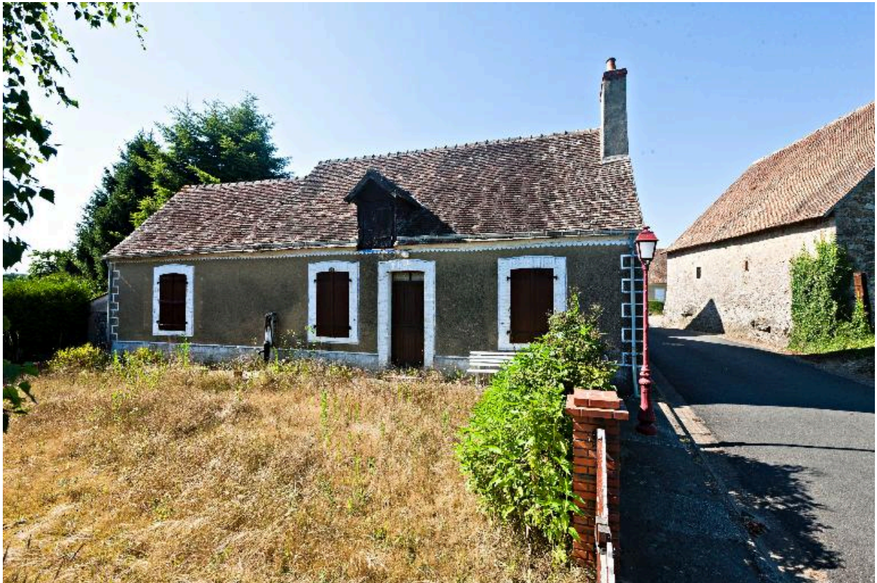
Maison 10, route de La Bosse, construite avant 1835 et remaniée au milieu du XXe siècle
