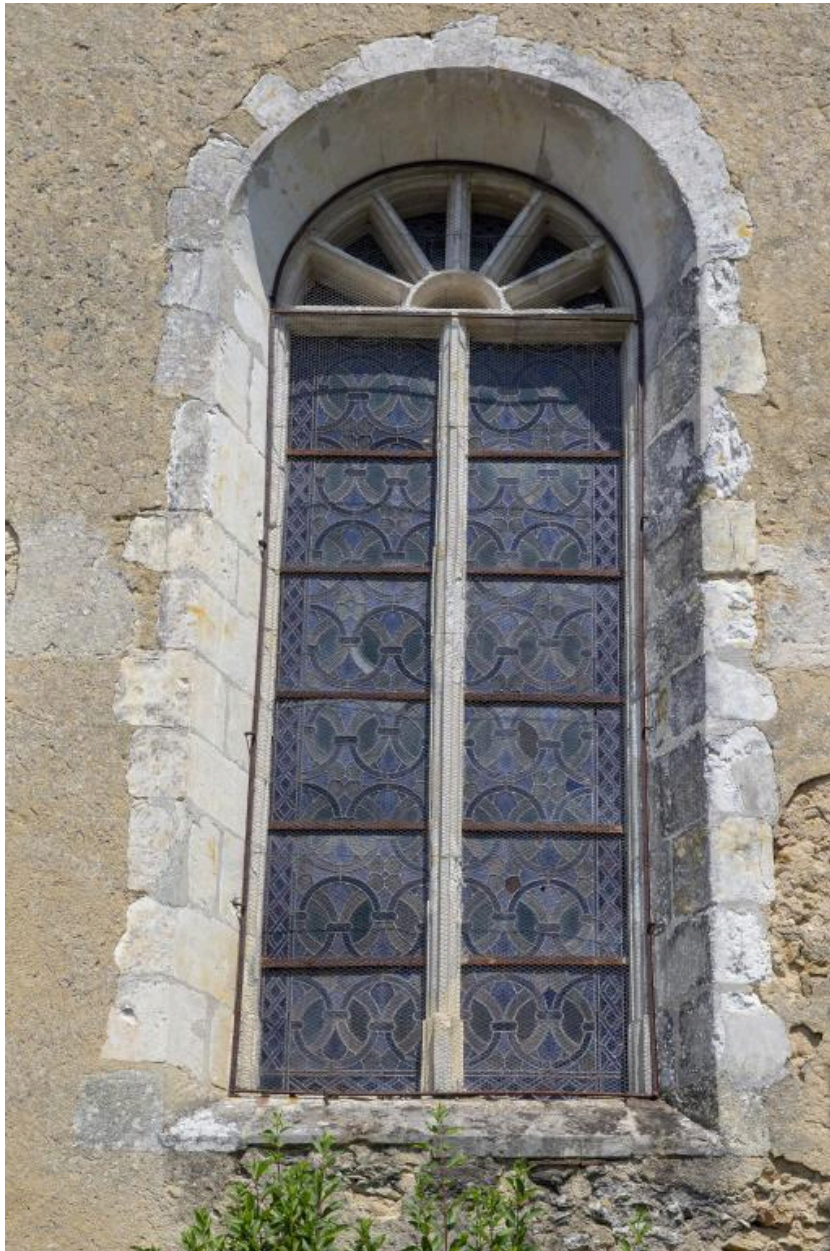
Une fenêtre du mur sud.
