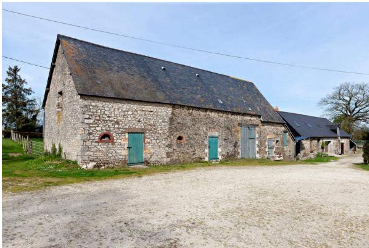
Corps de bâtiment nord-ouest.
