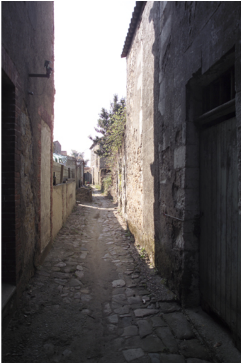
Vue de la ruelle vers le sud, à droite, la porte d'accès à l'immeuble n° 17.
