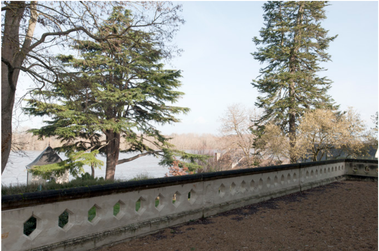
Terrasse, face à la Loire, avec garde-corps ajouré d'hexagones à moulurations néogothiques.
