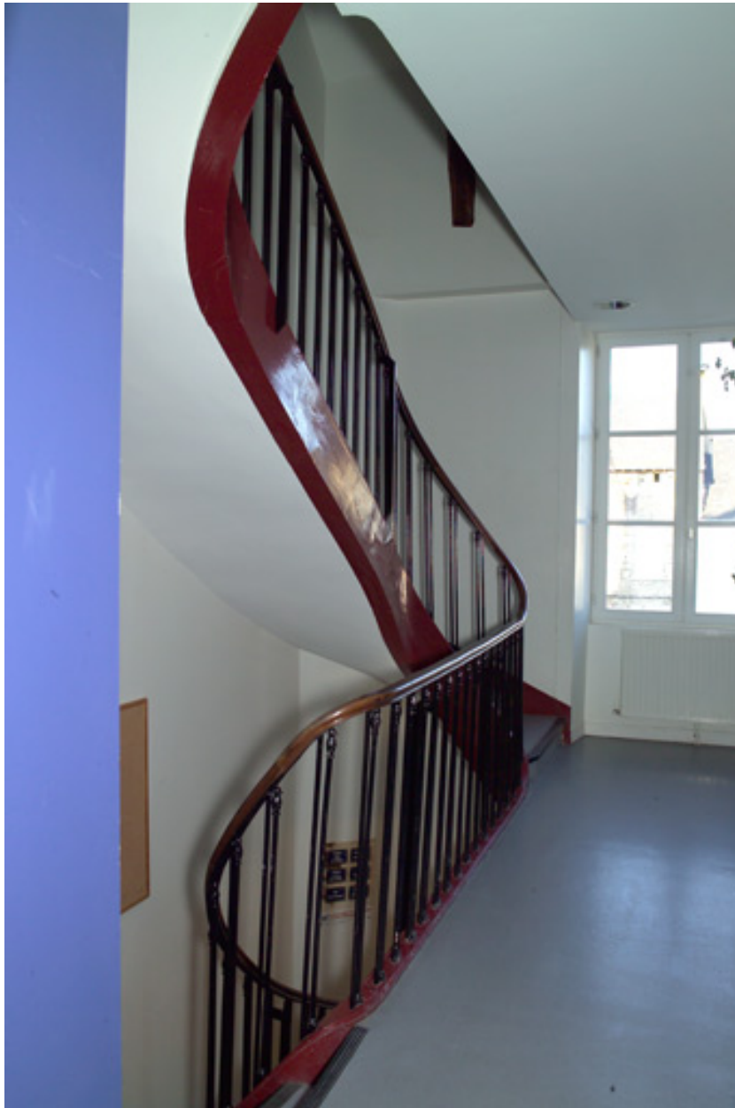
Escalier, premier étage.
