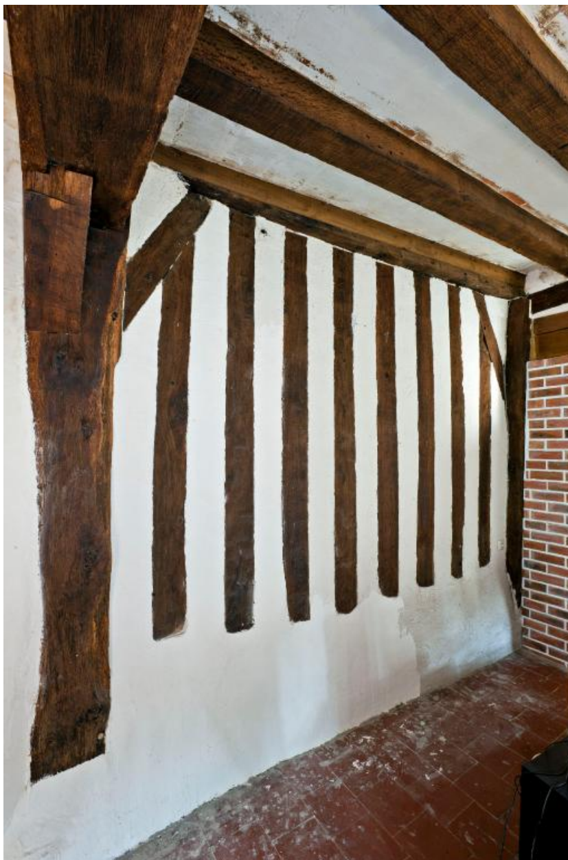
Maison, chambre à feu (ouest) : mur postérieur en pan de bois maçonné.
