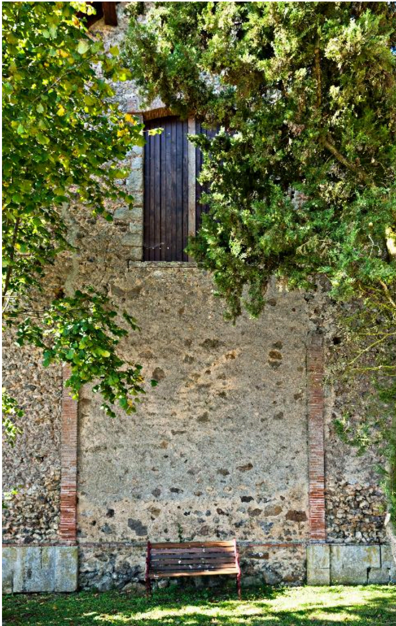
Porte bouchée dans le mur-pignon droit de la grange.
