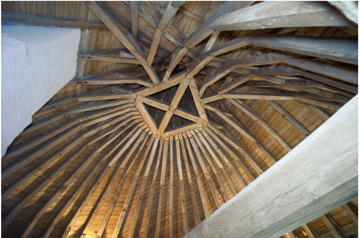
Vue de la charpente, couverture de tour.
