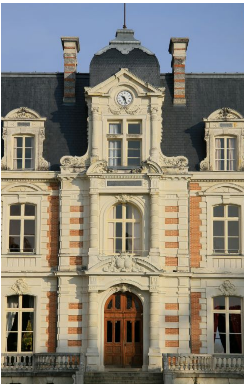
Façade antérieure : travée centrale.
